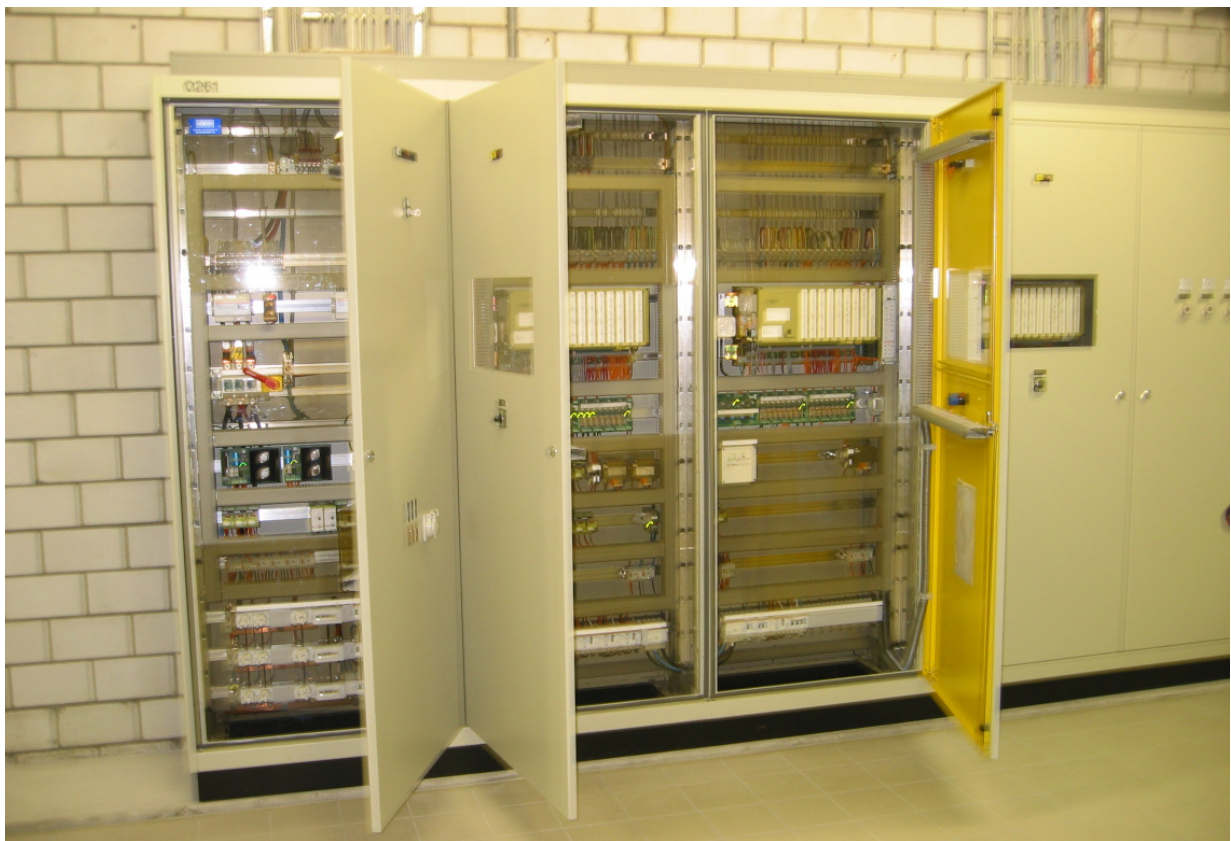
Schaltgeräte- Kombination mit MSRL- System EY2400
